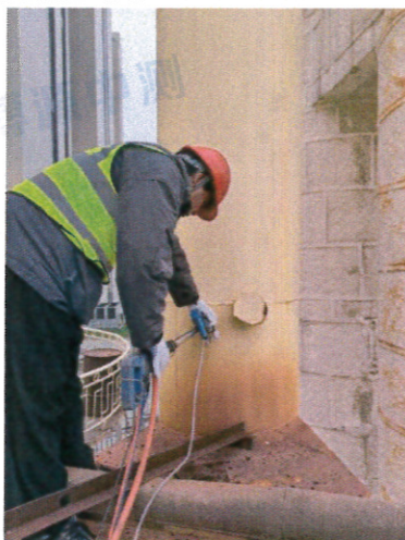
天然气锅炉排气筒
