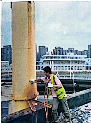
2#天然气锅炉排气筒
